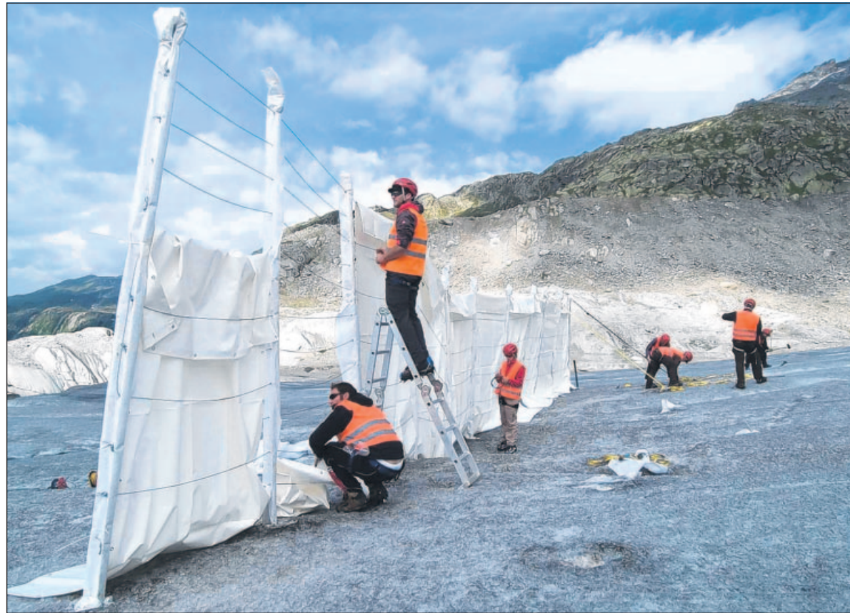
Anfang August auf dem Rhône-Gletscher: Die Mainzer Studenten befestigen die Planen an ihrer Windfang-Konstruktion.
